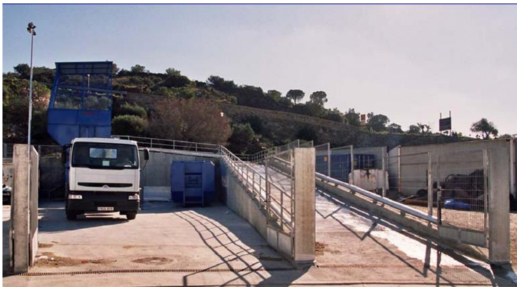
Fig. 13: Stazione di trasferimento con opere in muratura (rampa).
